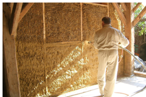
Die Strohdämmung in der Holzständerwand kann zum Beispiel direkt mit Lehm verputzt werden
