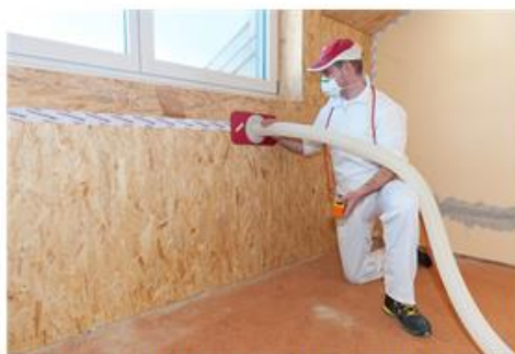
Beim Dachausbau wird Zellulose in Hohlräume eingeblasen
