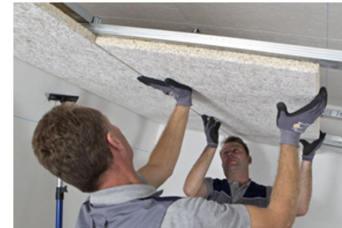
Zementgebundene Holzwohle-Dämmplatten verbessern Raumakustik und Brandschutz
